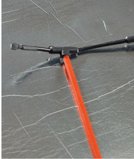
Рис. 5. Изоляция конца полосы UNIMAT
