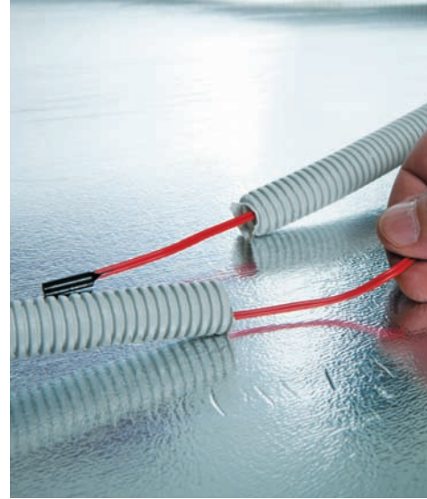
Рис. 18. Установка датчика температуры пола SF в гофрированную трубку (конец).
