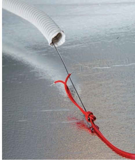
Рис. 17. Установка датчика температуры пола SF в гофрированную трубку (начало).
